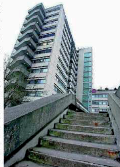
Das heutige Bettenhochhaus entspricht nicht mehr den Anforderungen an eine qualitativ gute
